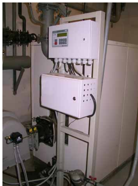
Рисунок 3,4. Котел «ФАКЕЛ» с горелкой Lamborghini. Заказчик «Альянс-Электро». г. С-Пб Полостровский пр. д.60
